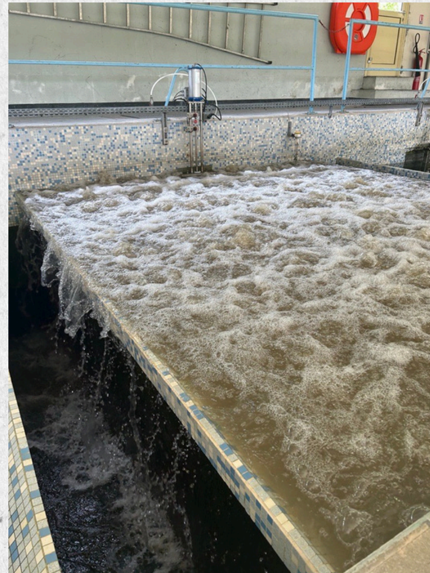
Fonctionnement du bac à décantation
